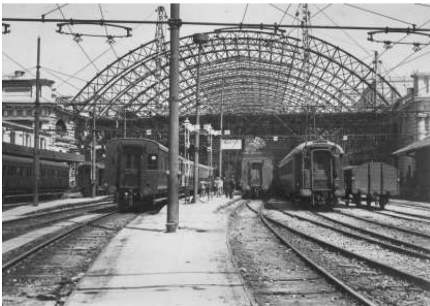
Un'immagine delle opere per la demolizione della tettoia nel luglio 1942
